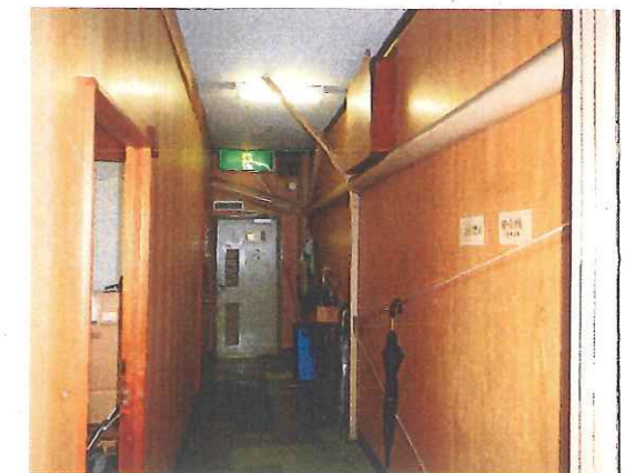
塔屋1階 廊下 (鉄骨造)
