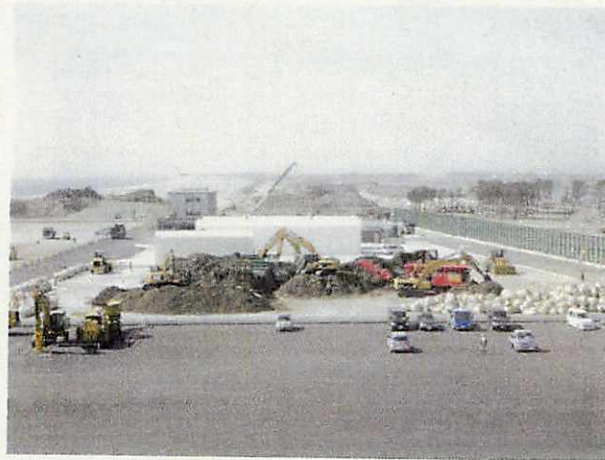
破碎選別ヤード
