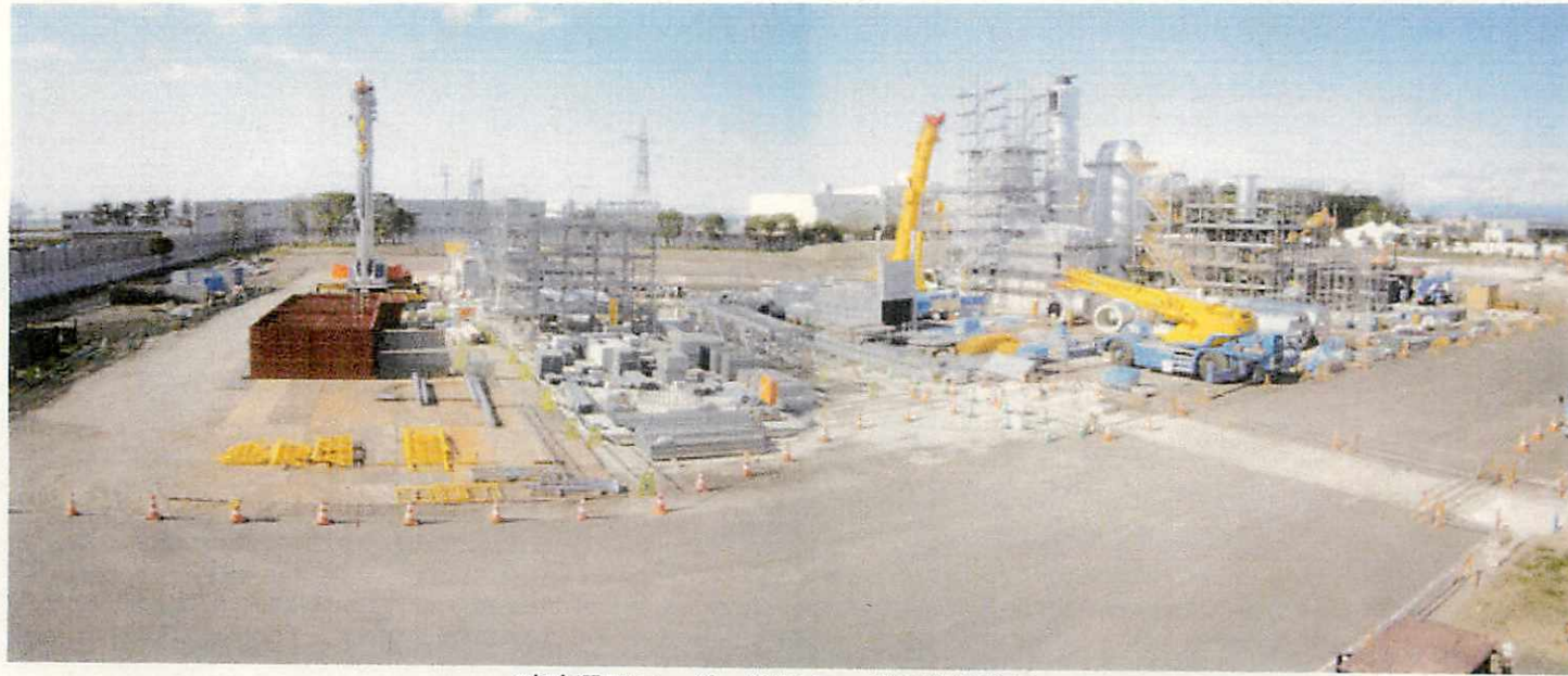
破碎選別ヤード・焼却ヤードの整備状況
