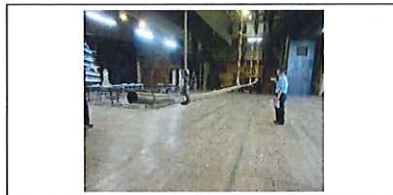
バトンのレイアウト及びバトンとすこの耐荷重の不足の課題あり
